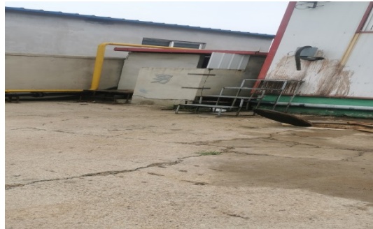
污水处理站周围地面硬化
