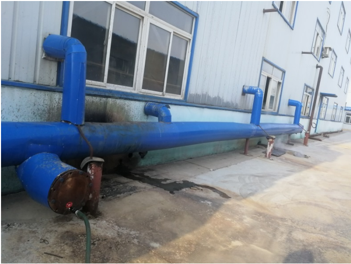
生产车间周围地面硬化
