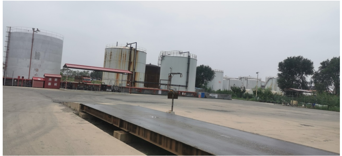
罐区周围地面硬化
