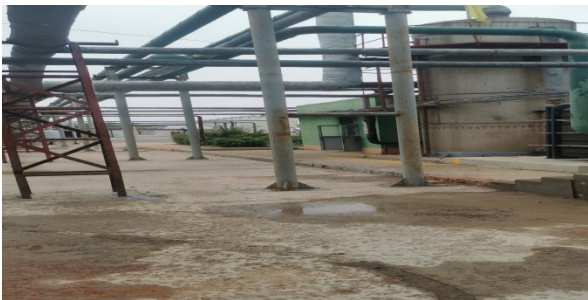
生产装置周围地面硬化
